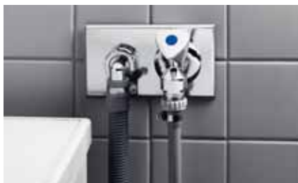
Zápachové uzávěry s integrovaným přítokem vody
