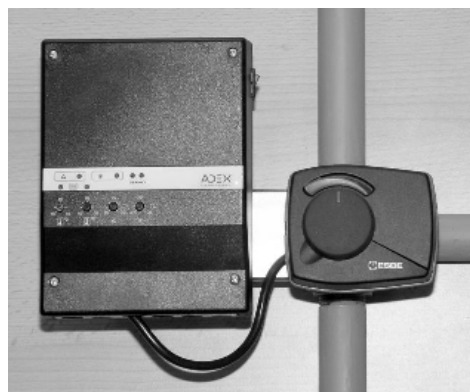
Obr. 23 Regulátor upevněný na držáku vedle servopohonu
