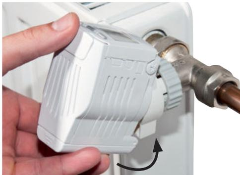
4.5 Pomocí vhodného šroubováku otočte páčku HD13 směrem k ventilu, pro dokončení montáže.
