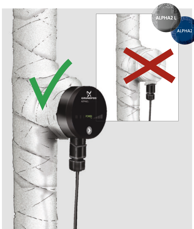
Obr. 5 Izolace tělesa čerpadla
