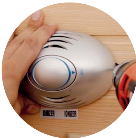
Instalace ionizátoru
