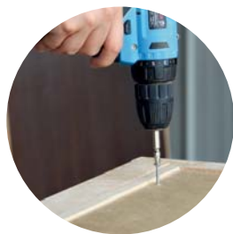
Přípevnění krytu stropu
