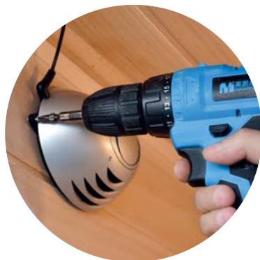
Příšroubování ionizátoru
