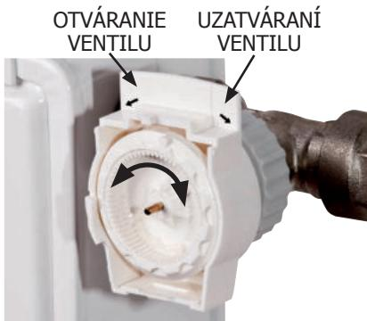
Zložte teleso z prevodovej časti, ventil nastavte manuálne otáčaním ozubeného kolieska podľa obrázku.
