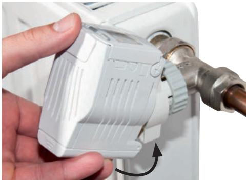
4.5 Pomocou vhodného skrutkovača otočte páčku HD13-L smerom k ventilu, pre dokončenie montáže.
