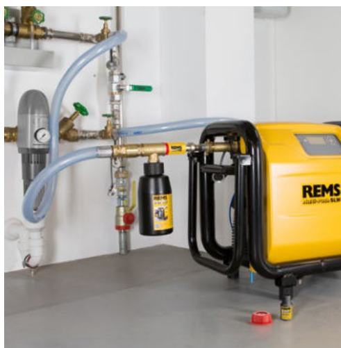
Dezinfekce rozvodů pitné vody
