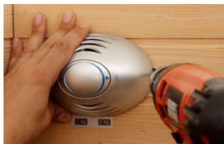
Foto č. 20 – přišroubování ionizátoru
