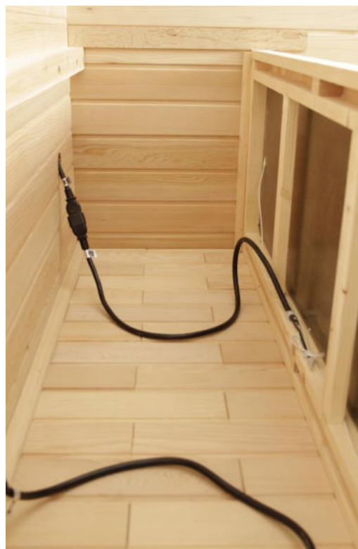
Foto č. 9 – kabely topidla propojená s kabely v zadní stěně
