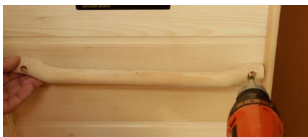
Foto č. 21 – přišroubování držáku na ručníky
