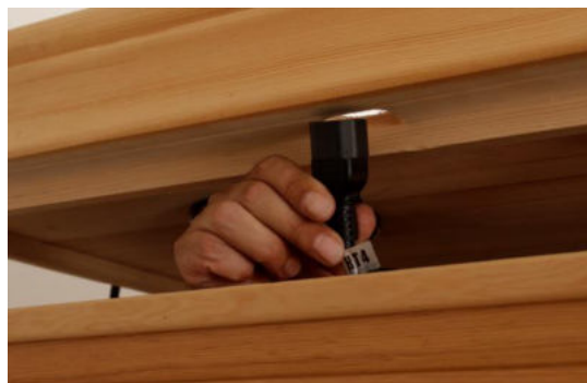
Foto č. 15 – protažení napájecího kabelu topidla skrz strop
