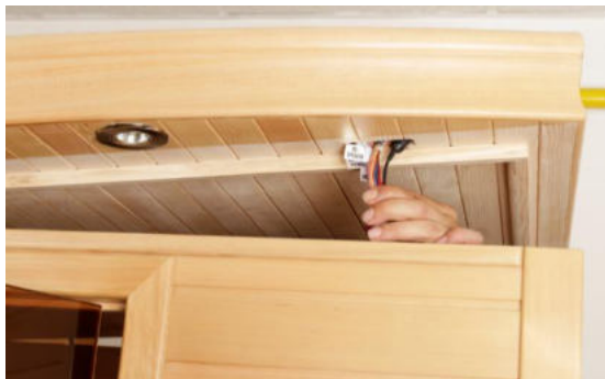
Foto č. 14 – protažení svazku kabelů ovládacího panelu od čelní stěny do stropu
