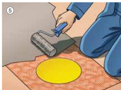
5 Zapracování utěšňovací manžety Schlüter-Kerdi do tekuté stěrkové izolace.
