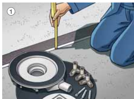
1 Změřte stavební výšku podlahy, zde: 85 mm.
