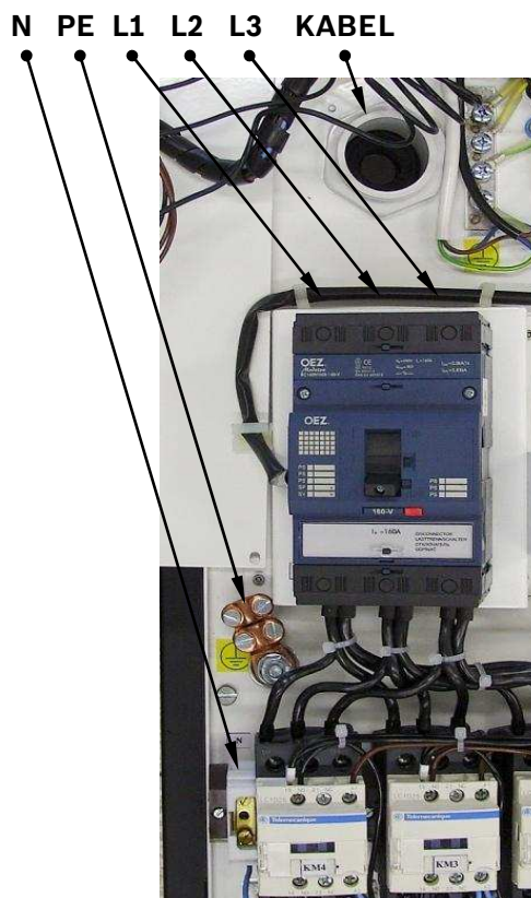
Obr. 20 Připojení přívodního kabel kotle Daline PTE 4 - 18
