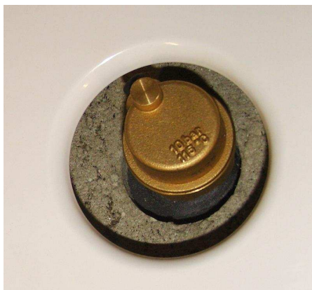
Obr. 14 Odvzdušňovací ventil kotlového tělesa
