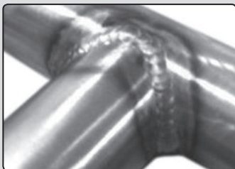
Obr. 6, Edelstahlrohre mit TIG-Methode geschweißt
