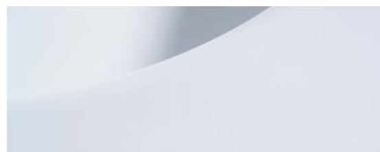
Akrylát po opravě
