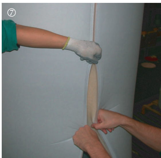
Obrázky znázorňující postup montáže izolace z měkké pěny s PVC fólií na nádrž.
