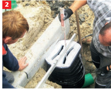
2 Optimale Ausrichtung des Ablaufs inkl. Aufsatz durch die Drehbarkeit, Teleskopierbarkeit und Anpassung an die jeweilige Quer- bzw. Längsneigung
