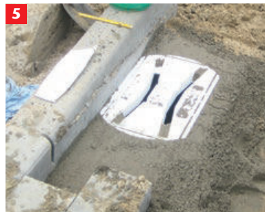
5 Erhöhtes Betonaufleger C 12/15 umlaufend für Aufsatz zur Lastaufnahme bzw. -ableitung mithilfe der Schalungshilfe ausbilden
