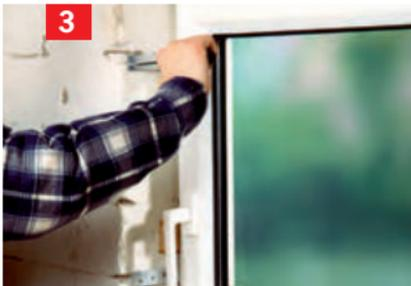
Das einwandfrei öffnende und schließende Fenster mit Befestigungsanker festsetzen, Funktionen kontrollieren.
