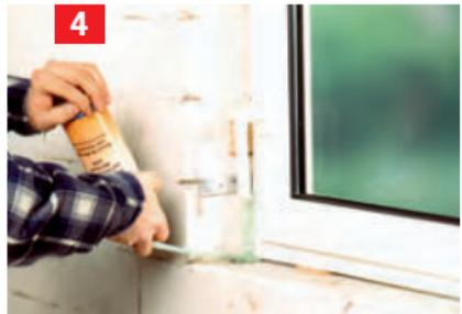
Fenster zum Fixieren nur an den Eckpunkten mit Zwei-Komponenten-Bauschaum ausschäumen! Beim anschließenden vollständigen Ausschäumen der Hohlräume muss der Rahmen gegen Verspannungen gesteuert werden.
