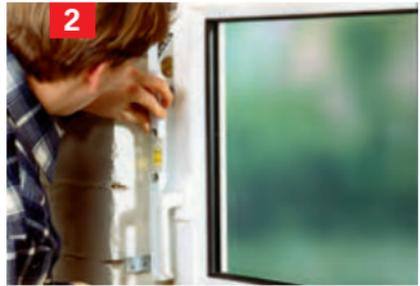
Kippflügel ausbauen bzw. Dreh/Kippflügel öffnen. Durch den Blendrahmen in das Mauerwerk bohren und verschrauben (Eckabstand 15–20 cm!), Kippflügel wieder einsetzen.
