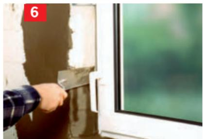
Fugen innen dampfdicht und außen schlagregendicht und diffusionsoffen abdecken. Zum Abschluss das neue Fenster sauber einputzen.
