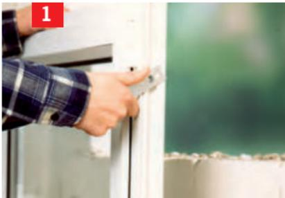
An jeder Fensterecke einen Befestigungsanker eindrehen. Das Fenster in die Maueröffnung stellen, mit der Wasserwaage ausrichten und in den Ecken mit Keilen fixieren. Anschließend vorsichtig eine Funktionskontrolle durchführen.
