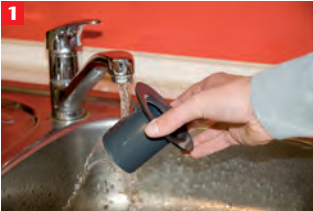
1 Den Geruchsverschluss unter Wasser säubern
