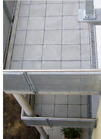
Offene Rinne mit Entwässerung über die Dachabdichtung: Balkone mit ACO Self® Highline
