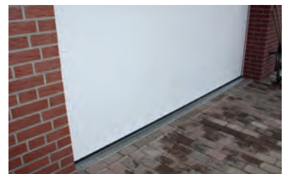
12. Fertiggestellter Rinnenstrang in der Pflasterfläche vor der Garage. Die Rinne entlastet die Schwelle und verhindert aufspritzendes Wasser im Torbereich.
