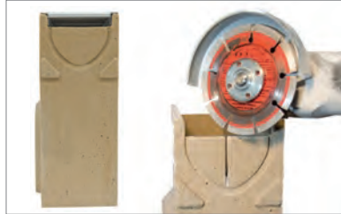
2. Zum Anschließen des Rinnenkörpers die Vorformung am Einlaufkasten mittels Winkelschleifer mit Diamantscheibe wie abgebildet mittig einschneiden...
