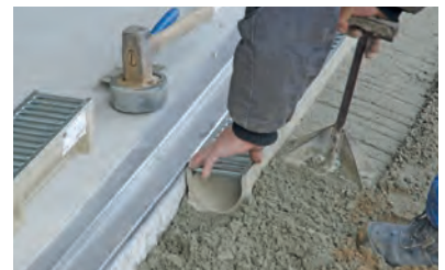
9. Seitliche Betonstütze gemäß Einbauempfehlung herstellen
