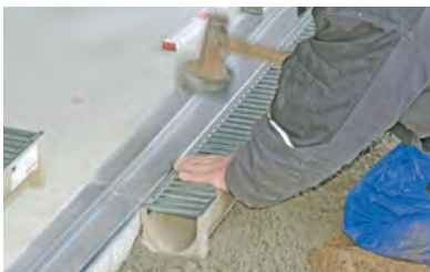
7. Ansetzen des Rinnenkörpers an den Einlaufkasten. Ausrichten des Rinnenstrangs. Die 2 cm Garagenschwelle ist so ausgeführt, dass das Tor zwischen Schelle und Rinne schließt.
