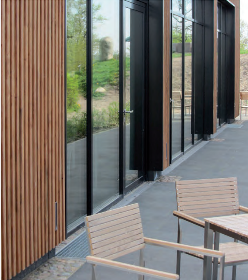
Geschlossene Rinne mit Anschluss an die Entwässerung: Terrasse mit ACO Self® Euroline
