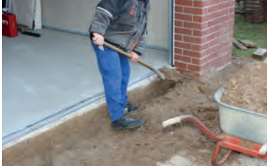
1. Bodenaushub nach Einbauempfehlung für ACO Self® Euroline: Rinnenstrang mit Einlaufkasten. (Einbaudetails zum Download unter: www.aco-hochbau.de/service/technische-dokumente/ )
