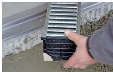
8. Anbringen der Stirnwand vor dem Setzen des letzten Rinnenkörpers. Siehe auch Seite 15.
