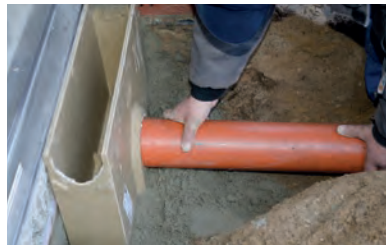
5. KG-Rohr mit Gleitmittel in den Einlaufkasten einsetzen.
