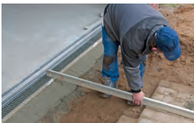
10. Ermitteln bzw. festlegen der Gefällesituation. Das Pflaster sollte so angearbeitet werden, dass der Rinnenstrang 3-5 mm unterhalb des Pflasters verläuft.
