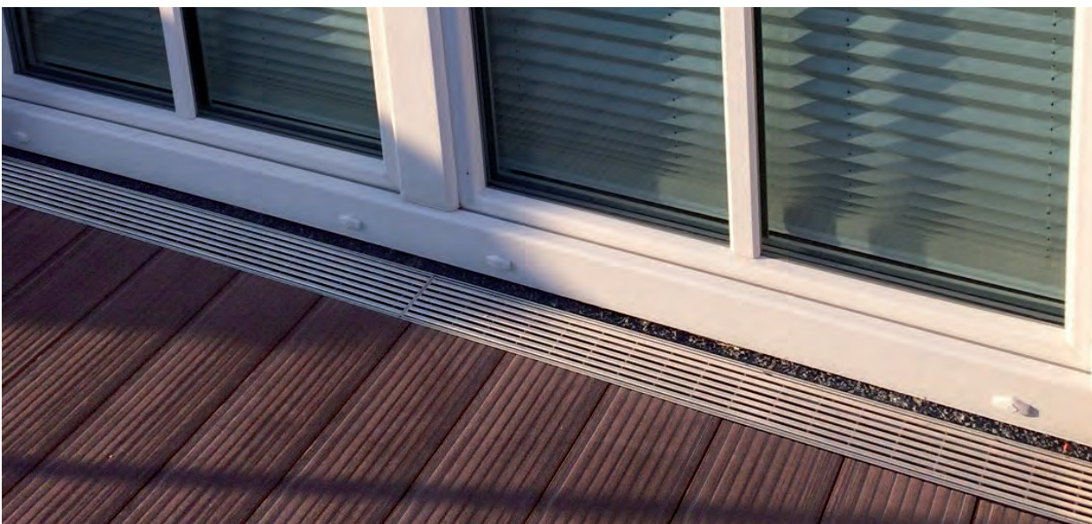
Offene Rinne ohne Anschluss: Terrasse mit ACO Self® Highline
