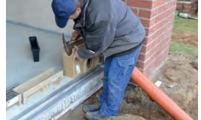
3. ... und von außen nach innen mit einem Hammer ausschlagen.
