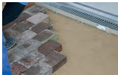
11. Pflaster an den Rinnenstrang anarbeiten.
