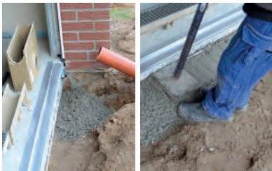
4. Einbringen des Rinnenfundamentes gemäß Einbauempfehlung. Verdichten des Rinnenfundamentes. Vorbereiten des Ablaufes DN 100.
