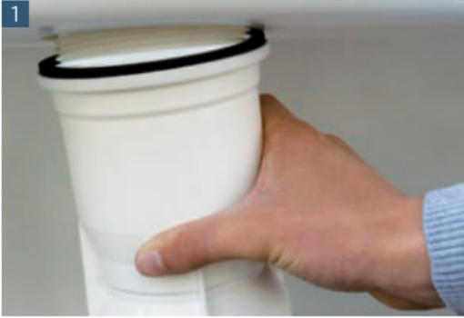
Den Einschraubring von oben durch die Lichtschacht-Entwässerungsöffnung führen. Den Grundkörper von unten auf den Einschraubring schrauben.
