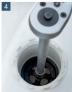
Die Rückstaeinheit von oben in den Grundkörper führen. Beim Einschrauben auf den korrekten Sitz des Gewindes achten. Drehmoment: 5 Nm
