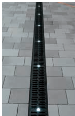
Eyeleds / Kunststoff Abstand LED-Leuchten 50 cm
