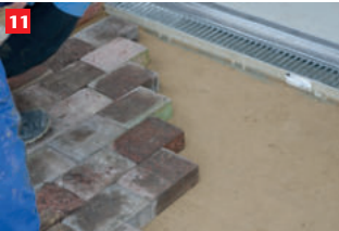
11 Pflaster an den Rinnenstrang anarbeiten.
