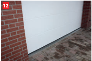
12 Der fertiggestellte Rinnenstrang in der Pflasterfläche vor der Garage entlastet die Schwelle und verhindert aufspritzendes Wasser im Torbereich.
