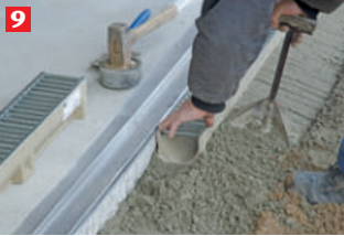
9 Seitliche Betonstütze gemäß Einbauempfehlung herstellen
