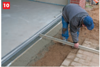
10 Ermitteln bzw. festlegen der Gefällesituation. Das Pflaster so anarbeiten, dass der Rinnenstrang 3-5 mm unterhalb des Pflasters verläuft.
