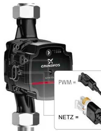
Abb. 30 Anschlüsse an der Elektronikeinheit
