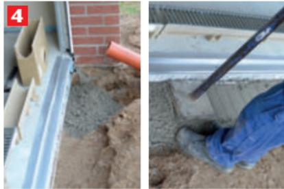
**4** Einbringen des Rinnenfundamentes gemäß Einbauempfehlung. Verdichten des Rinnenfundamentes. Vorbereiten des Ablaufes für KG-Rohr DN/OD 110.
