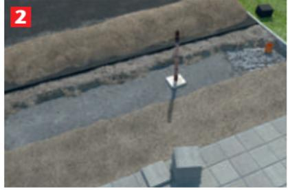
Den erdfeuchten Magerbeton (C 15/ B 15) in den Graben füllen und verdichten.
