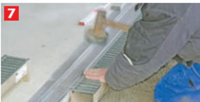
**7** Ansetzen des Rinnenkörpers an den Einlaufkasten. Ausrichten des Rinnenstrangs. Die 2 cm Garagenschwelle ist so ausgeführt, dass das Tor zwischen Schelle und Rinne schließt.
