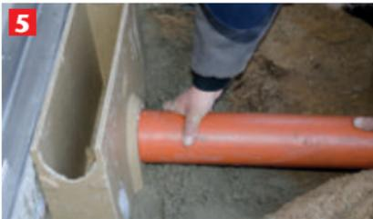
**5** KG-Rohr mit Gleitmittel in den Einlaufkasten einsetzen. Optional: Geruchsverschluss verwenden.
