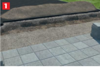
Graben für das Betonbett ausheben. Das Betonbett soll später ein Mindestmaß von 5 cm Höhe und 20 cm Breite haben. Wir empfehlen die vordere und die hintere Reihe der Pflastersteine auch mit in ein Betonbett zu setzen.
