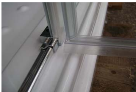
Spodní hranu dveří osadit těsněním apply the sealing on lower doorside.
