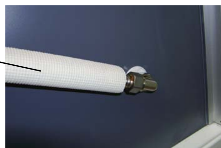
Vyústění páry Steam drainage
