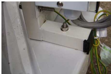
Použít šrouby M6x50 use screws M6x50
