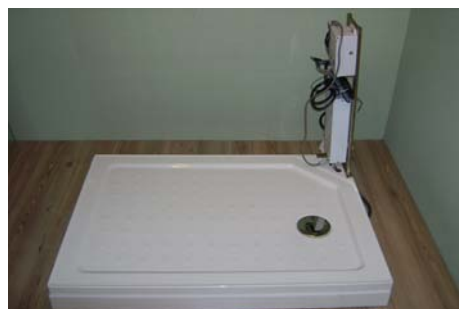
Instalovat generátor install the generator
