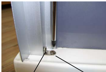
Použít šrouby 4,2x12 Použít šrouby 4,2x16 use screws 4,2x12 use screws 4,2x16
