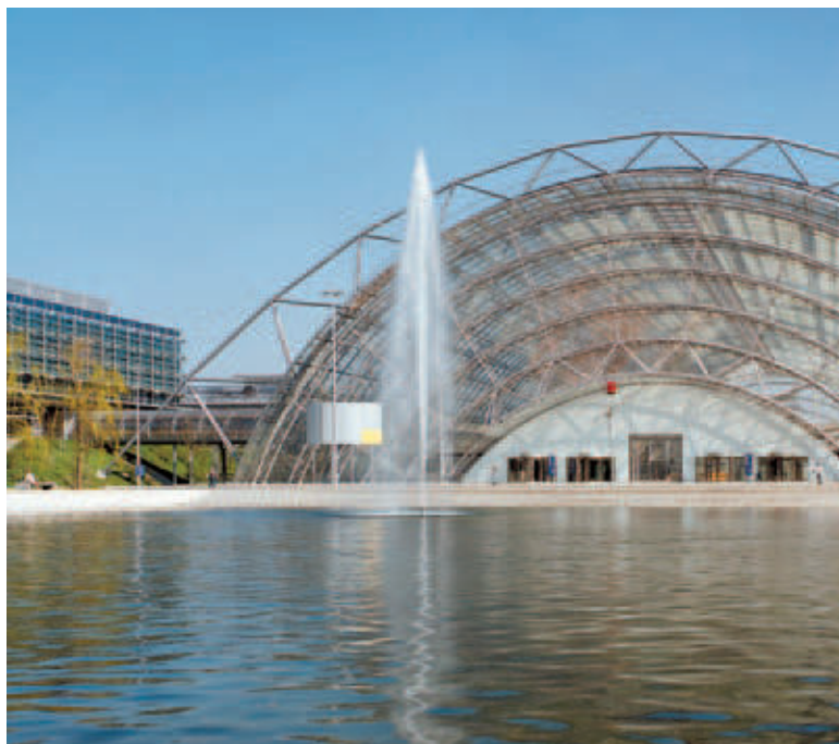
Výstaviště Lipsko: vybavené expanzním automatem gigamat
