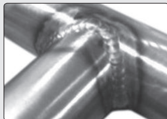
6. ábra. Rozsdamentes acélcső- vek hegesztése TIG eljárással
