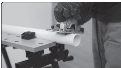
Abb. 20, Sägen eines PVC-Rohres
