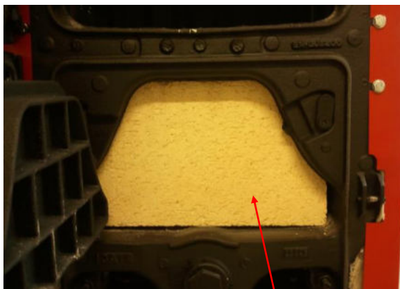
Obr. č. 9 Instalace šamotů
