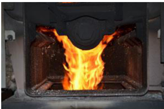
Obr. č. 13 Optimální tvar plamene
