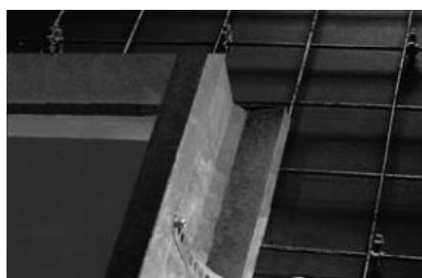
A keretet felfüggeszteni és odaszögelni
