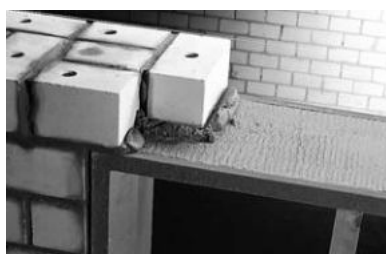
Stabil, alaktartó kötést kell létrehozni
