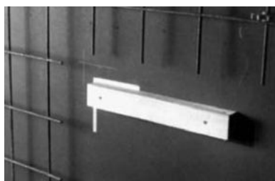
A sarok bejelölése a zsaluzaton, és a lécfeszítéssel
