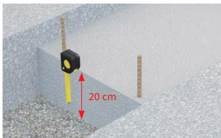
Zvolte místo odtoku (nejnižší místo), začátek a konec linie. Minimální výška betonového podkladu je 20 cm. Do betonového podkladu vložte betonářskou ocel Ø10 mm, každých 40 cm.
