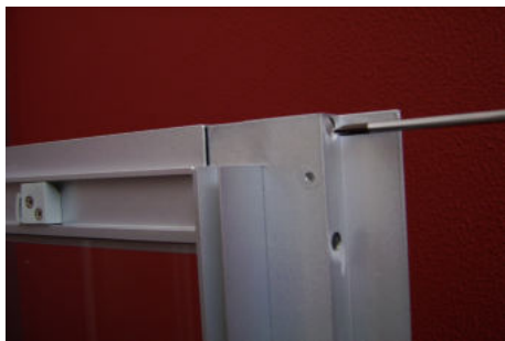
Horní strana. Sestavit sprchovou zástěnu. Použít šrouby 4x25 Upper part. Assemble the shower enclosure. Use screws 4x25
