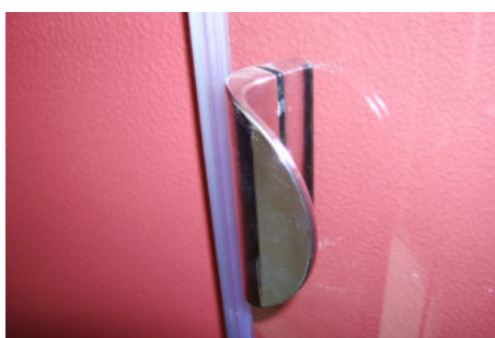
Instalovat madlo install the grab handle
