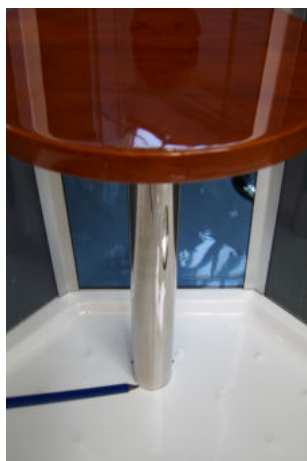
Označit umístění sedátka mark the positioning of the seat
