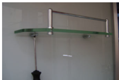
Instalovat policičku na boční díl install the shelf on the side panel
