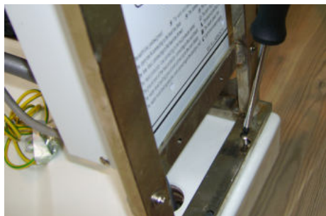
Použít šrouby 4,2x25 use screws 4,2x25
