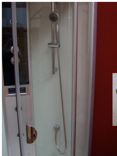
Instalovat ruční sprchu Install the hand shower
