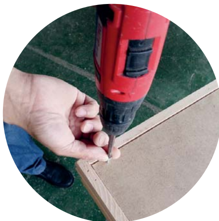
Instalace krytu stropu
