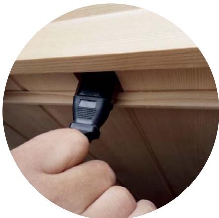
Ukázka protažení kabelů
