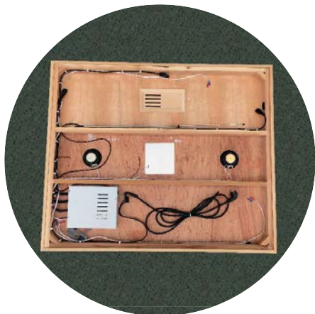
Vrchní část stropu
