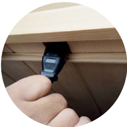
Ukázka protažení kabelů
