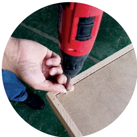
Montáž krytu stropu
