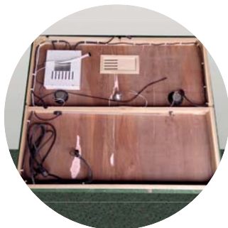
Náhled stropu z vrchní části.
