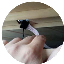
Ukázka protažení kabelů
