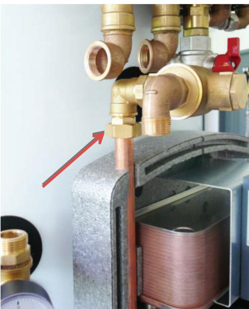
14. Namontovat solární čerpadlovou skupinu (kód 9909) pomocí 2 šroubů M6x16 s podložkou (kódy 12996 a 7853 – součást sady 12227).
