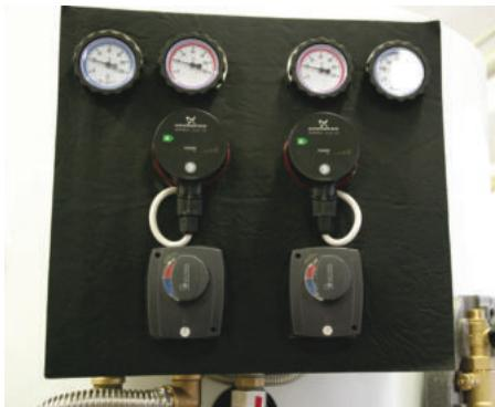
26. Na čerpadlovou skupinu se čtyřcestnými ventily nasadit plastový kryt a upevnit ho pomocí čtyř plastových šroubů M6x10 (kód 12713).
