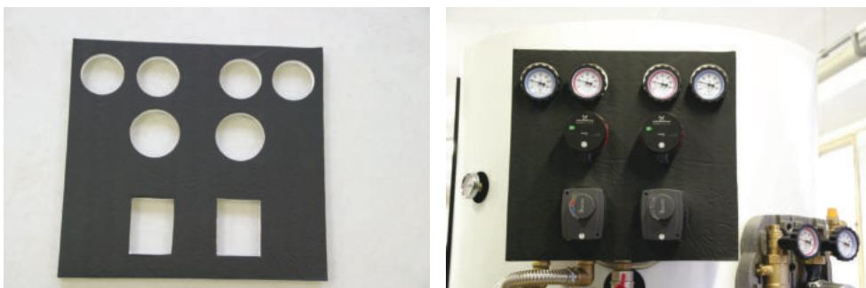
25. Připojit konektory čerpadel s kably, kably zasunout za izolaci.
