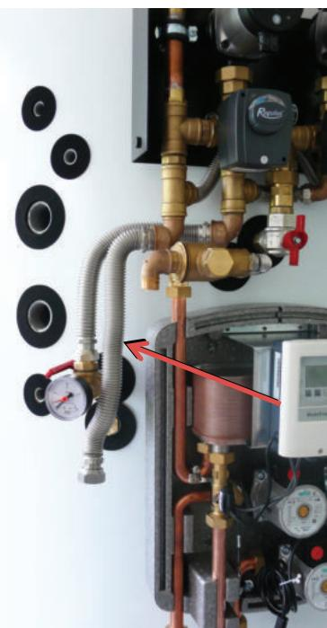
19. Na skupinu s T-kusy (kód 13983) namontovat trubky 3/4“ – 320 mm, 450 mm (kód 3041). Trubku délky 450 mm namontovat dle obr. vpravo.
