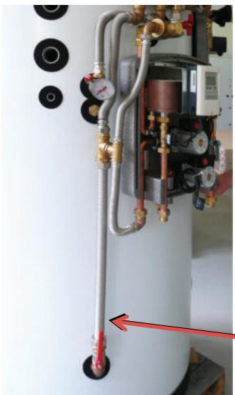
22. Namontovat 2 teploměry (kód 10474 - součást sady 13237). Zátky 6/4“ a 1/2“ nebo elektrická topná tělesa a havarijní termostat.
